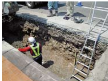
①掘削後敷砂
