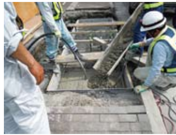
⑤生コン打設。周辺埋戻し。
