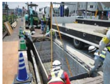
②KCスタンドフォーム据付け
