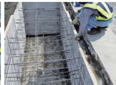
③型枠レベル調整
