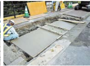
⑥所定高さまで打設。埋戻し・養生。
