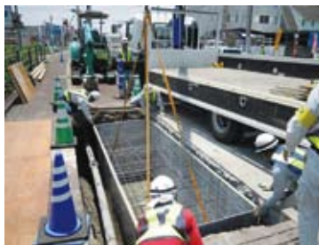
②KCスタンドフォーム据付け
