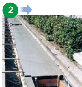
コンクリート打設
