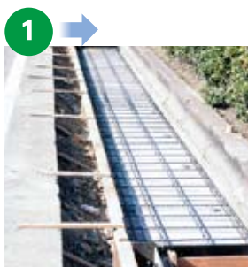
KCフォームの上に配筋した状態
