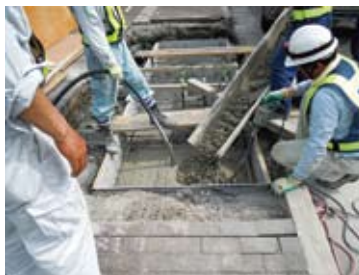
⑤生コン打設。周辺埋戻し。
