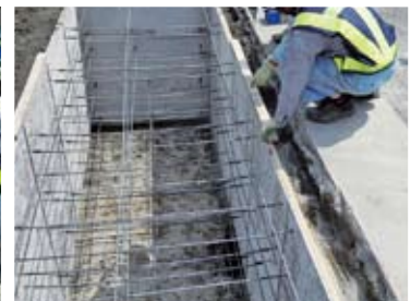
③型枠レベル調整
