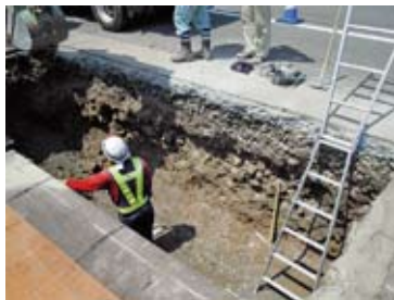
①掘削後敷砂
