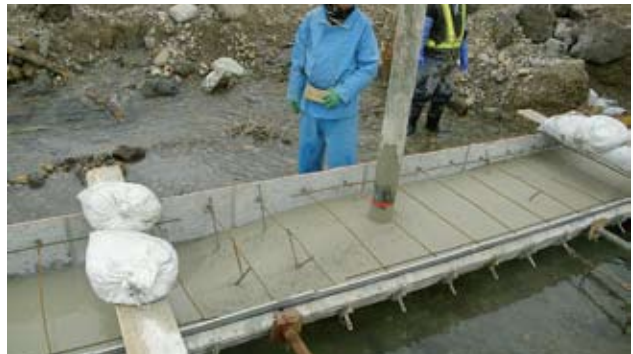
水中コンクリート打設
