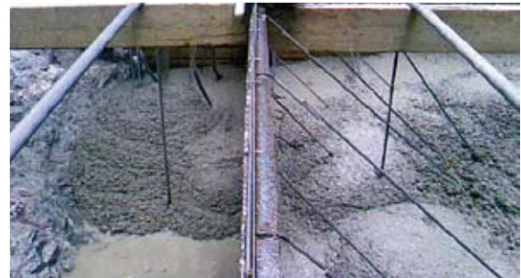
生コンは交互に打設。 生コン圧を打ち消しあい、補強を最低限に抑えます。
