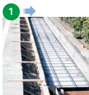
KCフォームの上に配筋した状態
