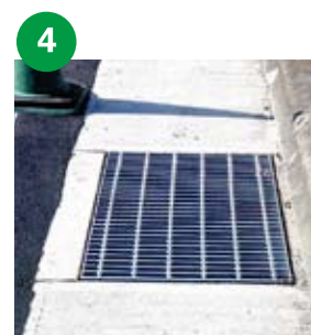
グレーチング設置
