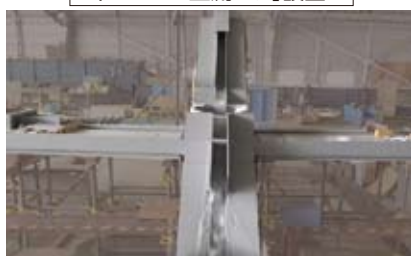
「マスマス整流ます」設置
