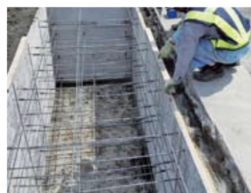
③型枠レベル調整
