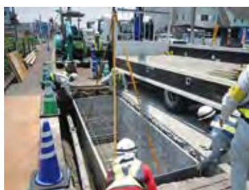
②KCスタンドフォーム据付け
