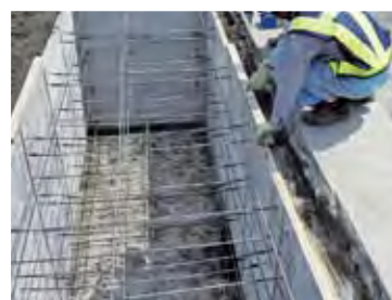
③型枠レベル調整
