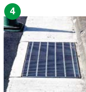
グレーチング設置
