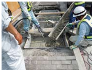
⑤生コン打設。周辺埋戻し。
