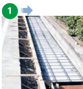
KCフォームの上に配筋した状態
