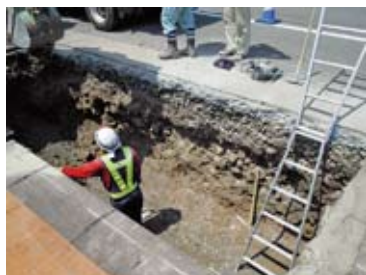
①掘削後敷砂
