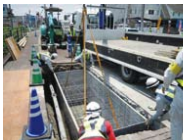
②KCスタンドフォーム据付け
