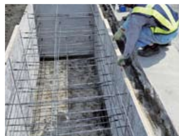
③型枠レベル調整
