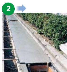
コンクリート打設
