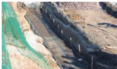
1.かごテンサー基礎敷設
