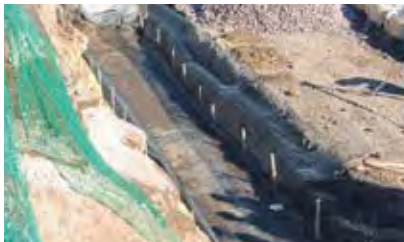
1.かごテンサー基礎敷設
