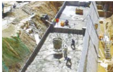
5.コンクリート打設状況
