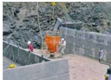
5.コンクリート打設状況
