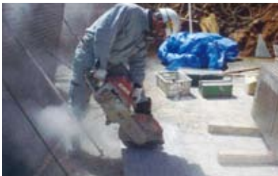
4.型枠パネル切断加工状況
