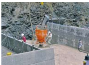
5.コンクリート打設状況
