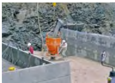
5.コンクリート打設状況
