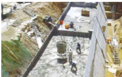
5. コンクリート打設状況
