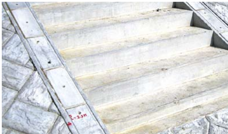
▲階段端部止工
