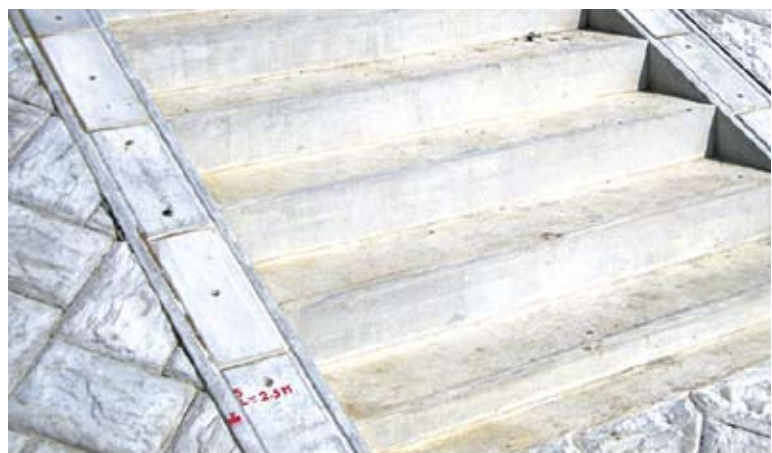
▲階段端部止工
