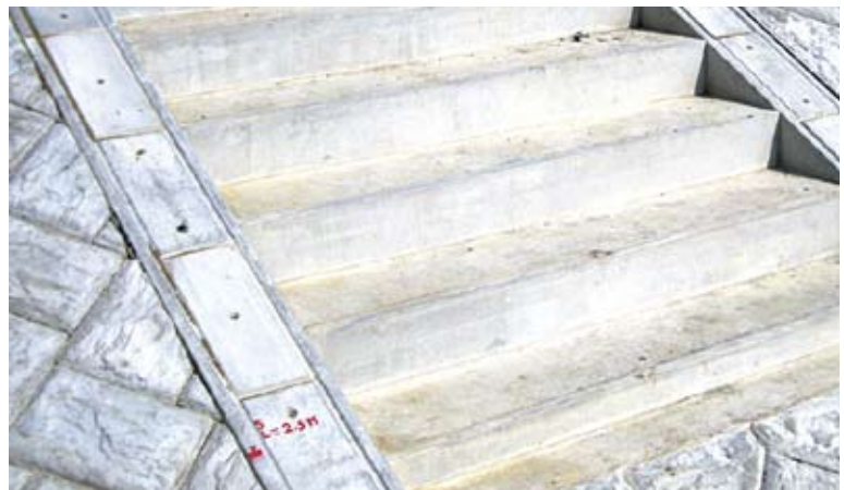
▲階段端部止工
