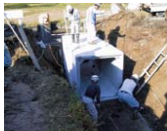
5. 普通型を据付
