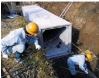
7. PC鋼より線を4穴に通す
