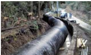
▲上水道管(誘導管)
