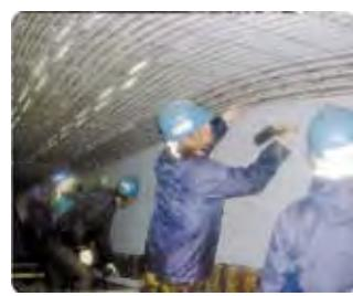
嵌合部材、表面部材を人孔から運び入れ、鋼製リングに取り付けます。
