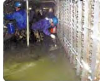
分割された鋼製リングを人孔から運び入れ、ボルト結合により鋼製リングを組み立てます。
