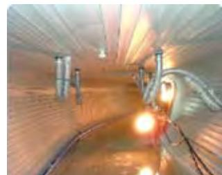
既存管渠と表面部材との間に高流動・高強度充填材を注入します。
