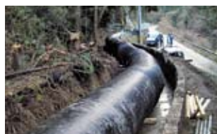
▲上水道管(誘導管)
