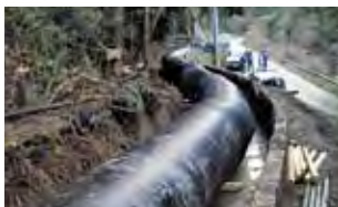
▲上水道管(誘導管)
