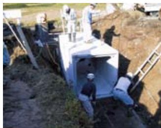
5. 普通型を据付
