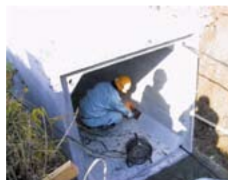
12. 最後のカップリング付ボックスの部分でPC鋼より線を定着した後、切断
