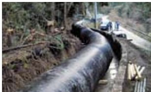
▲上水道管(誘導管)
