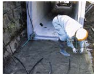
9. 最後のカップリング付ボックスに緊張用ジャッキをセット
