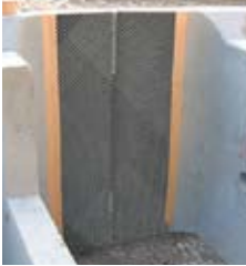
4.L型目地材(ネットシート)の設置
