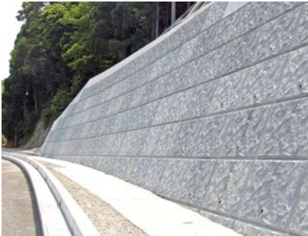
擬岩タイプ(階段積みもたれ式擁壁)
