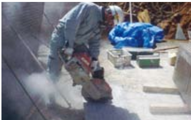
4.型枠パネル切断加工状況
