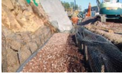
2.基礎単粒度碎石投入・かごテンサー連結
