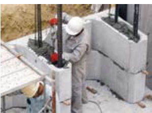
⑤ 縦貫コンクリート打設
