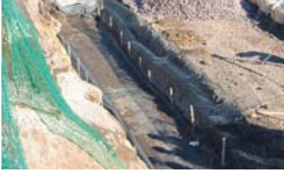
1.かごテンサー基礎敷設
