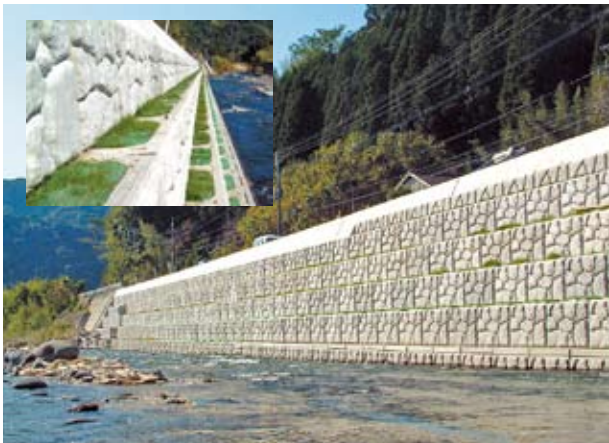
擬岩タイプ(階段積みもたれ式擁壁)
