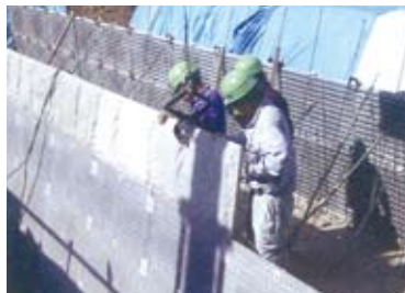
5.コンクリート打設状況
