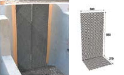
4.L型目地材(ネトロンシート)の設置
