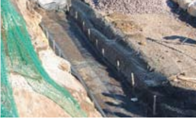
1.かごセンサー基礎敷設
