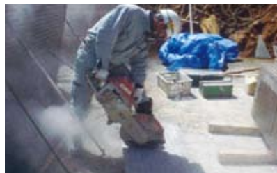
4.型枠パネル切断加工状況
