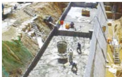
5.コンクリート打設状況
