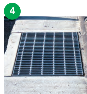
グレーチング設置
