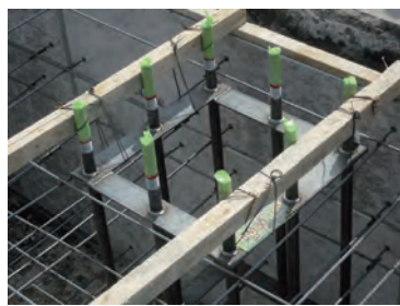
④アンカー筋設置
