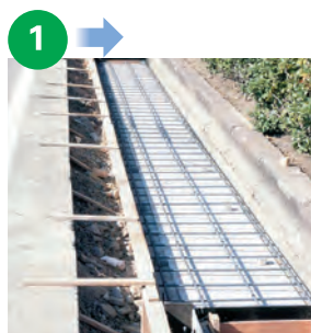
KCフォームの上に配筋した状態
