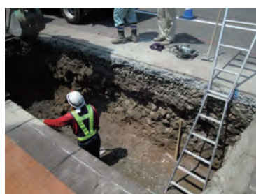
①掘削状況
