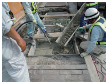
⑤生コン打設
