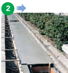
コンクリート打設
