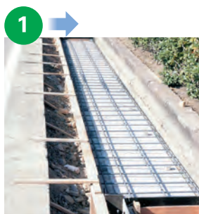
KCフォームの上に配筋した状態
