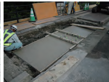
⑥仕上げ・養生
