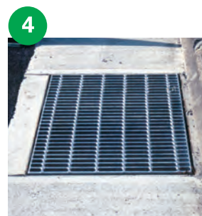
グレーチング設置
