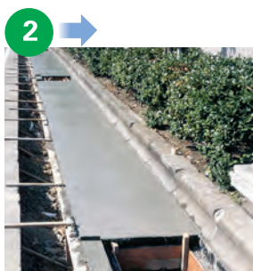
コンクリート打設
