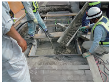
⑤生コン打設
