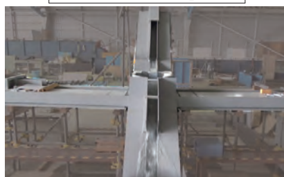
「マスマス整流ます」設置
