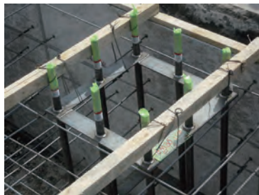
④アンカー筋設置
