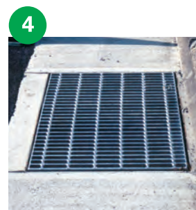
グレーチング設置
