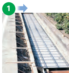
KCフォームの上に配筋した状態
