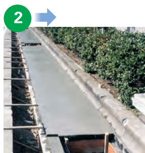
コンクリート打設
