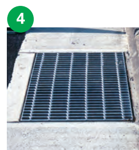
グレーチング設置
