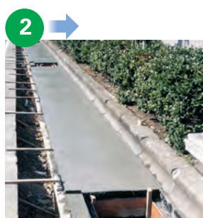
コンクリート打設
