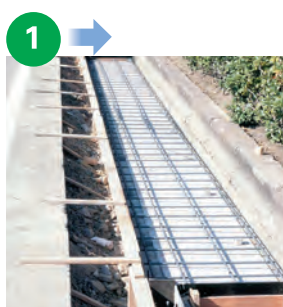
KCフォームの上に配筋した状態
