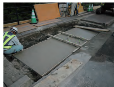
⑥仕上げ・養生
