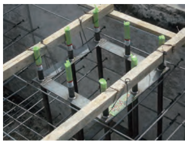
④アンカー筋設置
