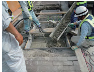
⑤生コン打設
