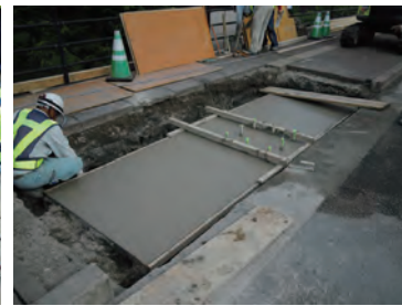
⑥仕上げ・養生
