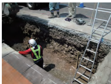
①掘削状況
