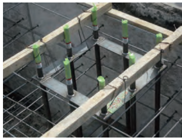
④アンカー筋設置
