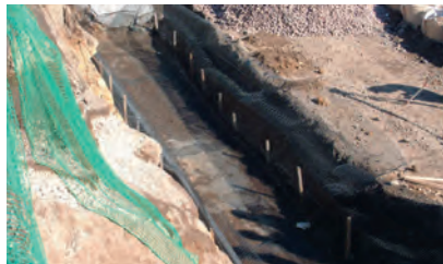
1.かごテンサー基礎敷設
