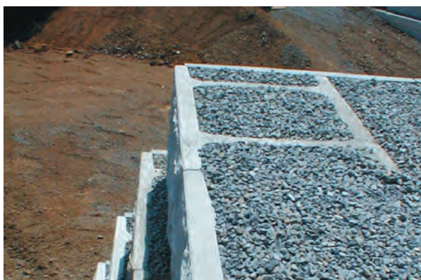
コーナー部の施工
