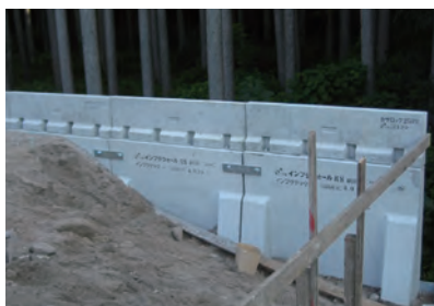
1. カサロックをL型擁壁に仮留めし、墨出し(高さの決定)を行います。
