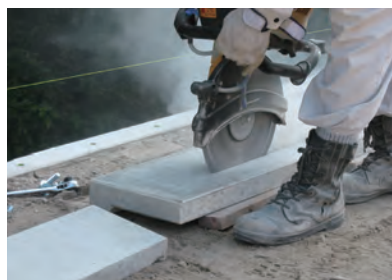
2. 角材等をカサロックの下に敷き、水平になるようにし、エンジンカッターで前面側から切断します。
