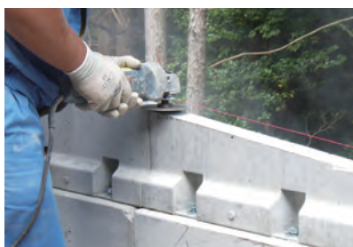
4. 切断面をサンダー等で仕上げます。
