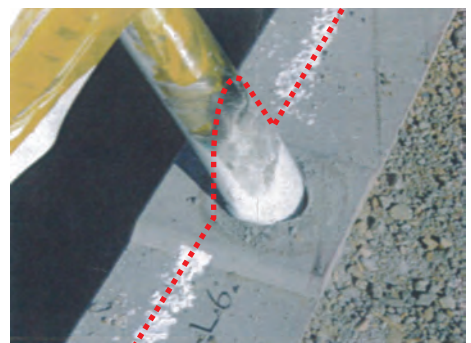
衝突試験(車両の最大進入工程=140mm)においても車輪が擁壁から逸脱することがありませんでした。
