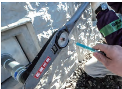
⑦ 補強鉄筋の定着
