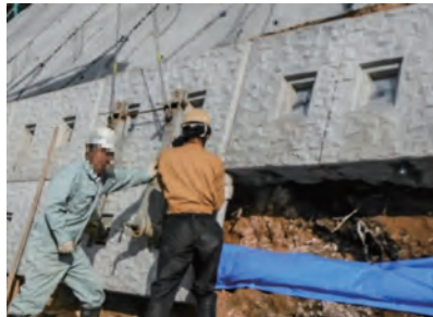
⑤ 補強鉄筋の削孔・挿入
