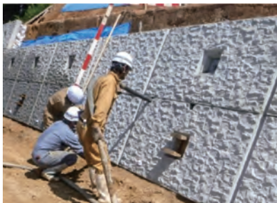
⑦ 補強鉄筋の定着
