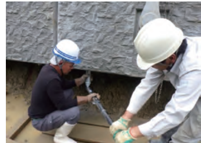
⑥ 補強鉄筋のグラウト
