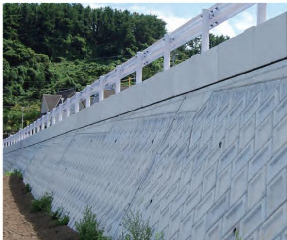
他擁壁上での使用例:補強土壁
