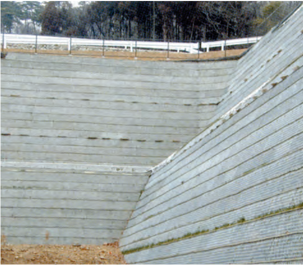
●巻込み無し工法(ユニットキャップ工法)
