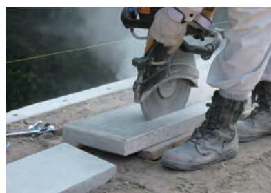
2. 角材等をカサロックの下に敷き、水平になるようにし、エンジンカッターで前面側から切断します。
