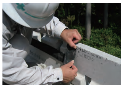
5. カサロック同士、カサロックとL型擁壁の接合部(背面側)に付属の止水テープを貼り、ボルト部をモルタルで埋めます。
