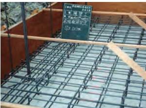
⑤ 縦貫コンクリート打設
