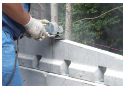
4. 切断面をサンダー等で仕上げます。
