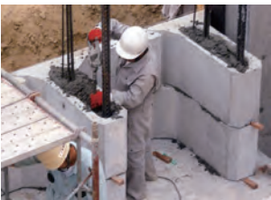
⑤ 縦貫コンクリート打設
