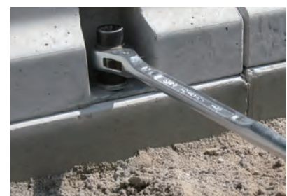
3. L型擁壁にカサロックを据え、付属のボルト、座金を使用しラチェット等で締め付けて固定します。
