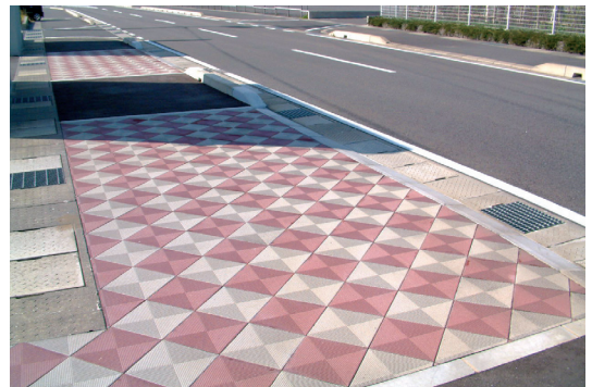
▲鹿児島県始良町(透水ユニプレーン)
