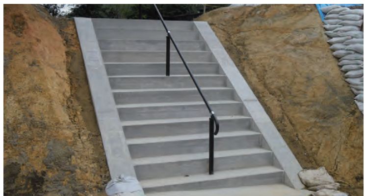
▲階段工での使用例
