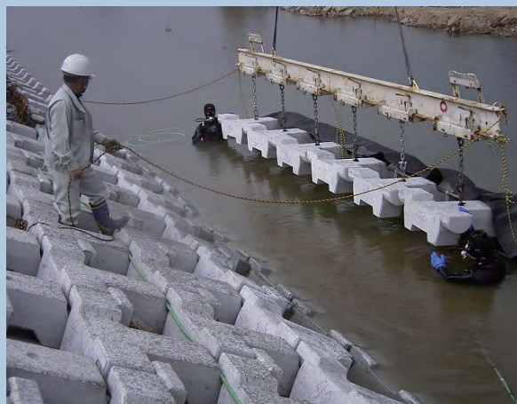
シート付ブロック6個を群体施工します。
