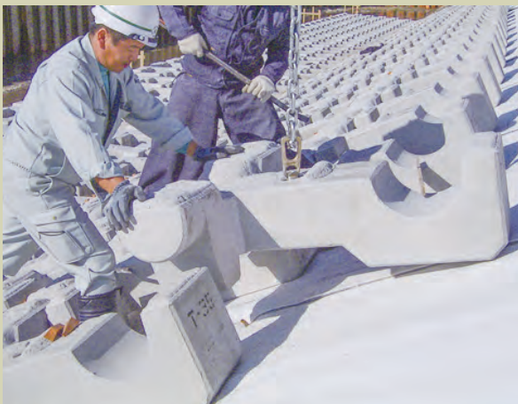
ブロックを単体で施工します。
