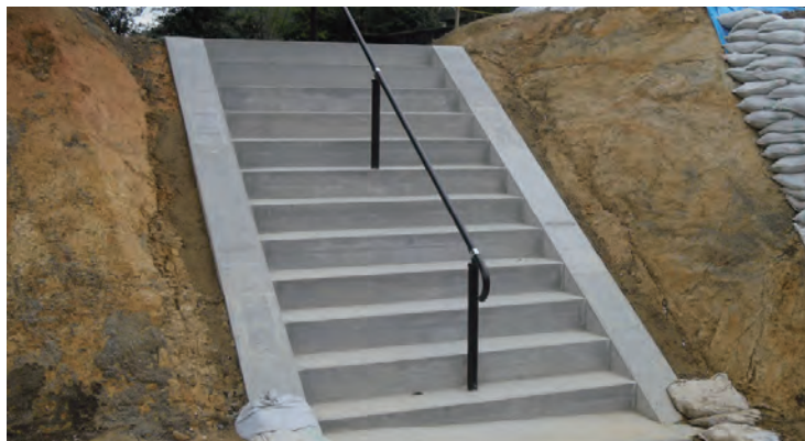
▲階段工での使用例
