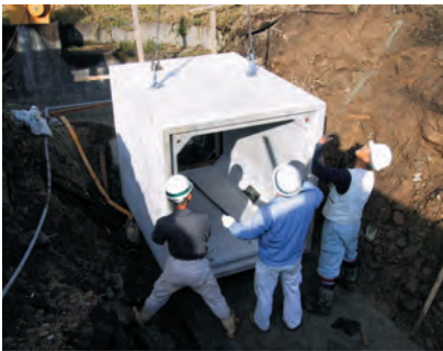
4. カップリング付ボックスを始めに据付
