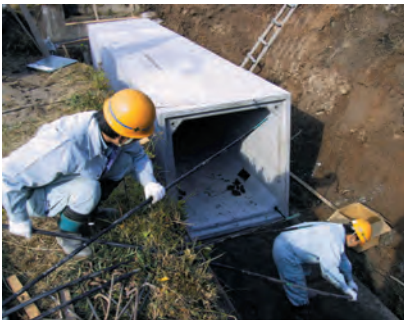
7. PC鋼より線を4穴に通す
