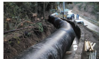
▲上水道管(誘導管)
