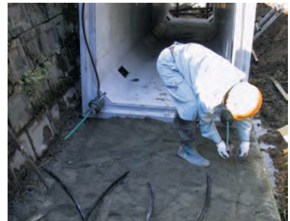
9. 最後のカップリング付ボックスに緊張用ジャッキをセット
