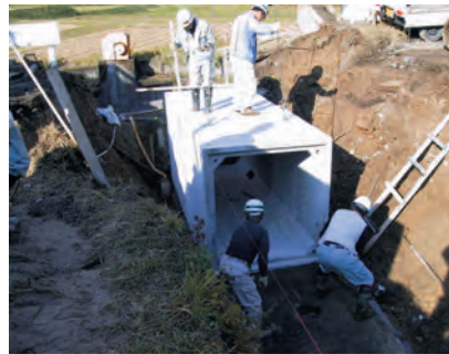
5. 普通型を据付
