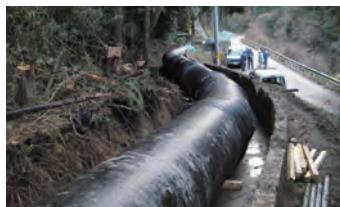
▲上水道管(誘導管)
