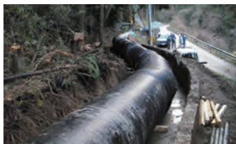
▲上水道管(誘導管)
