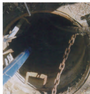
1 水槽内の水の汲み出し
