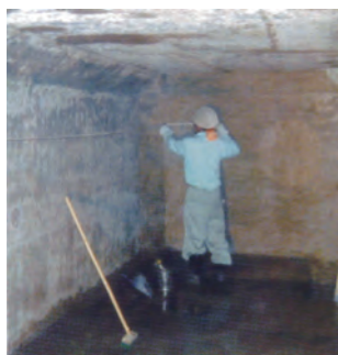
2 清掃及び採寸 藻等が躯体に付着している場合は 高圧水等で洗い流します。
