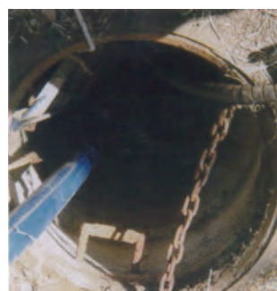
1 水槽内の水の汲み出し
