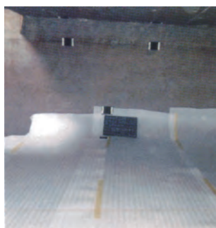
5 緩衝シートを貼付け
