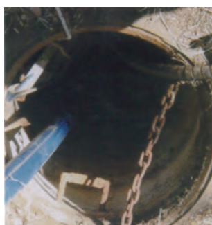
1 水槽内の水の汲み出し
