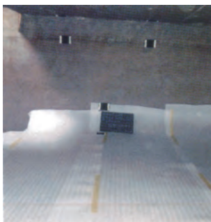
5 緩衝シートを貼付け
