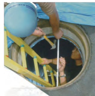
8 仕上げ作業 (固定金具で投入孔のシートを固定)
