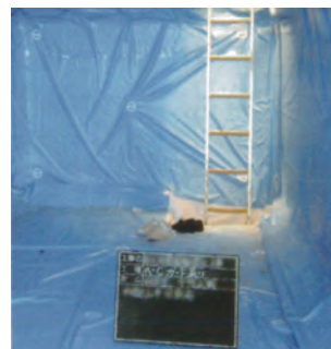
7 リーブシート貼付け完了
