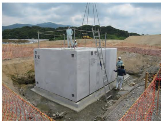
防火水槽(貯水槽)の頂版の上で作業する場合、落下防止の安全対策が必要です。製品には「セフティポスト(IN40型)」(株式会社フレックスシステム製)が取り付けられるインサートが埋め込まれています。
