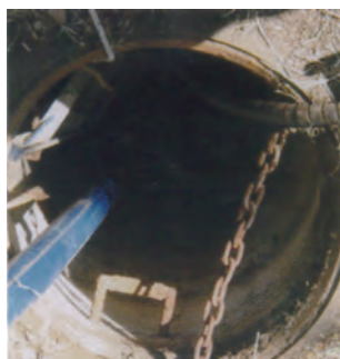
1 水槽内の水の汲み出し
