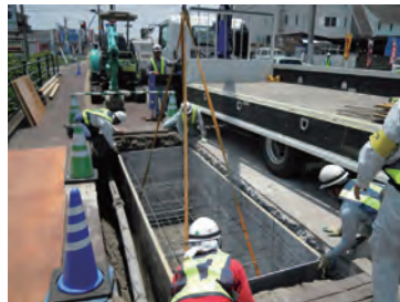
②KCスタンドフォーム据付け
