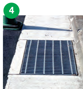
グレーチング設置
