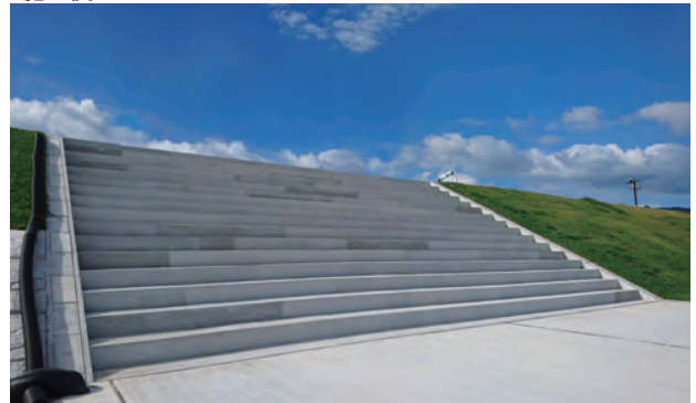
▲仙台東部道路のり面管理用通路設置工▲
