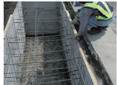
③型枠レベル調整
