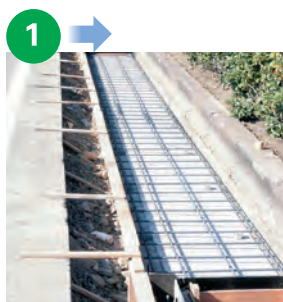
KCフォームの上に配筋した状態
