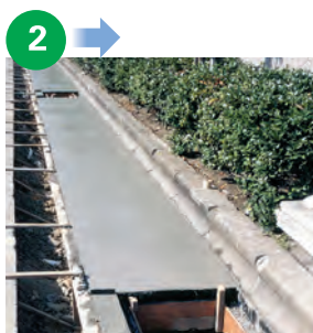
コンクリート打設
