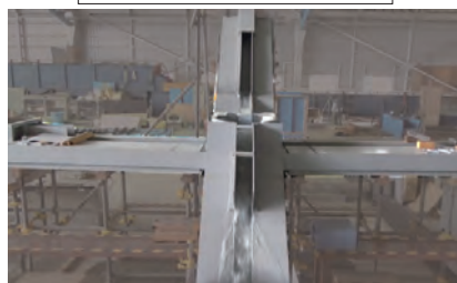
「マスマス整流ます」設置
