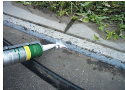
③ 製品1ロールは10m(Bタイプは3m)です。④ 溝の中に製品下部を押し込んでいきます。⑤ 最後の部分は、ハサミ等で切って調整してください。
