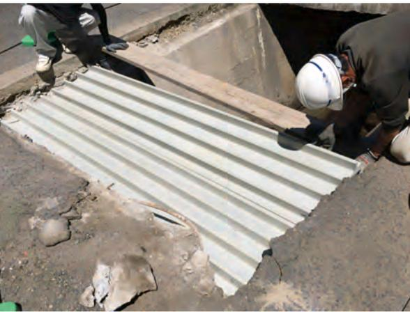
※コンクリート打設時の側圧でたわまないように製品にはキャンバー(緊張力による反り)がついています。
