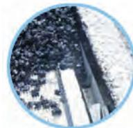
※側溝掛りとレインスルーの隙間にアスファルト合材等を充填することで、ガタツキを抑えます。
